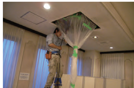
業務用エアコン洗浄
