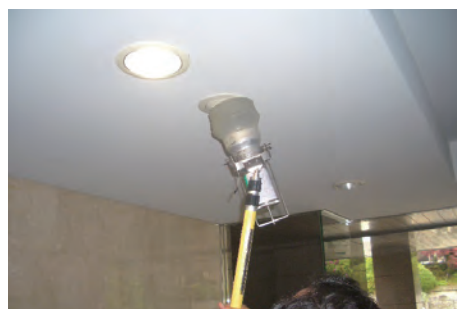
消防感知器点検作業
